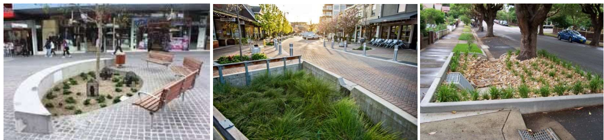
Figuur 8: Drie principes die passen in een watervoerende straat met doorvoerfunctie. Van links naar rechts: de boog aan deze rustzone vangt het water op dat vervolgens snel infiltreert en wordt getransporteerd met een drainage leiding. In het midden zien we een opvang bekken, gelegen in de buitenbocht waar water in grote debieten kan langs stromen. De onderbreking in de boordstenen zorgt voor een ingang met een hoge capaciteit. De grootte van dit bekken laat toe om enige vertraging in te bouwen. Rechts werd een bestaand boomvak vergroot, de ingreep rijkt relatief ver in de straat om zoveel mogelijk water te capteren. In dit geval werd de straatkolk eenvoudig toegankelijk gehouden omdat er weinig buffercapaciteit is en snelle afvoer dus noodzakelijk is.
