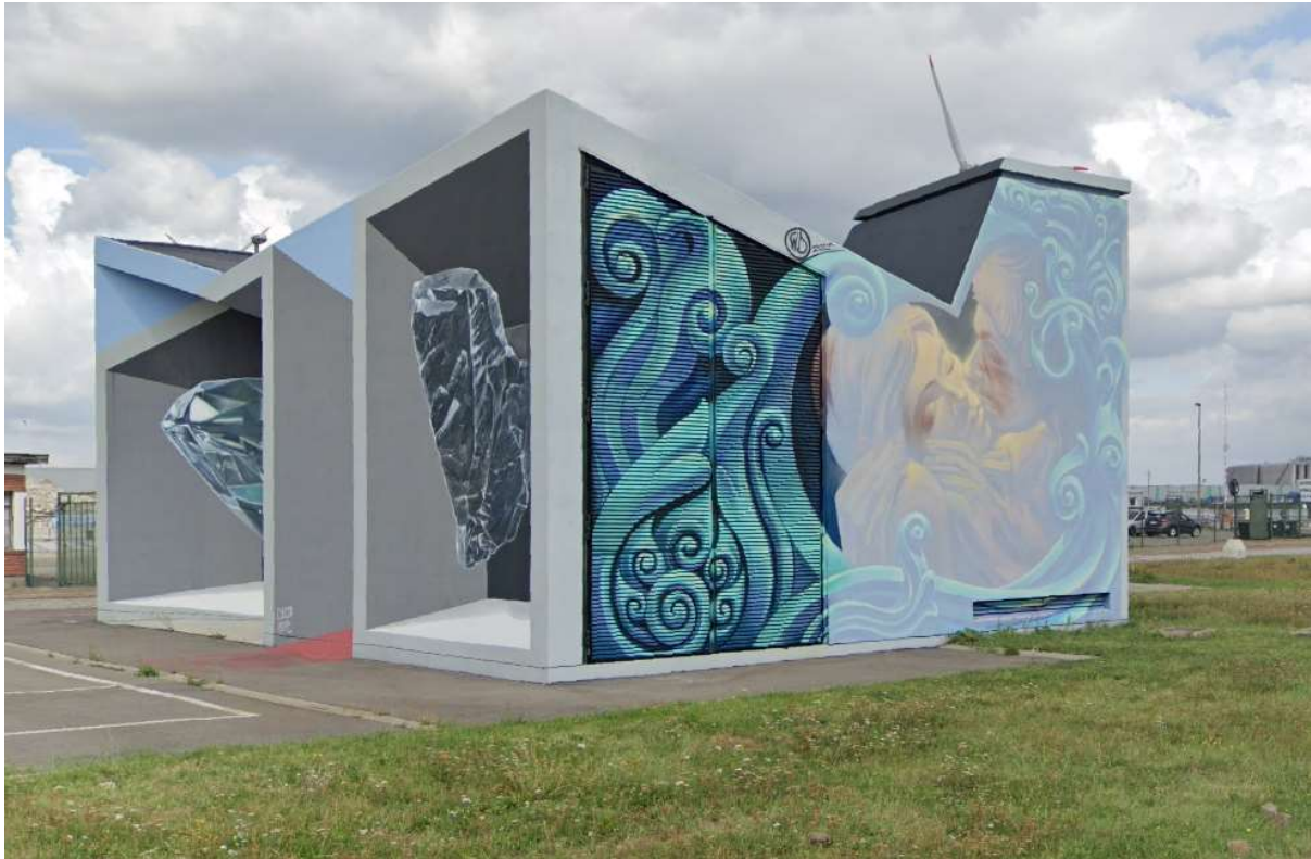
Figuur 40: Tijdelijke omhulling van een ijzerdosering ter hoogte van een Aquafin pompstation. De technische installatie werd op vraag van de gemeente omhuld met een op maat ontworpen gebouwtje dat later door een streetart artiest werd geschilderd.
