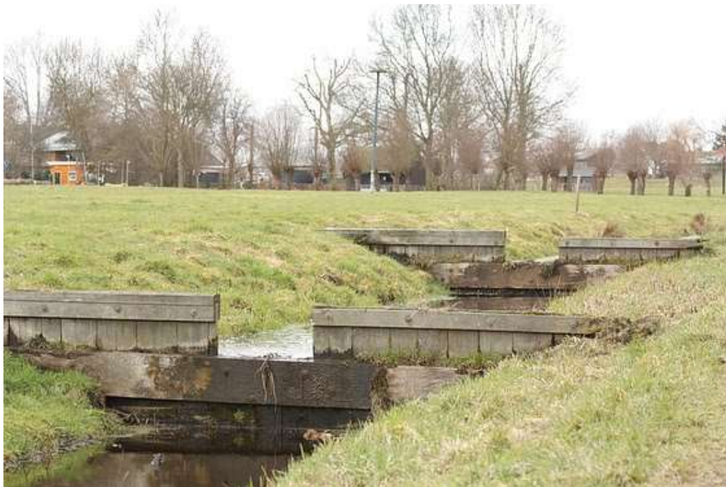
Figuur 43: Schotten in grachten vermijden dat al het water wegstroomt en zorgen voor voldoende infiltratie
