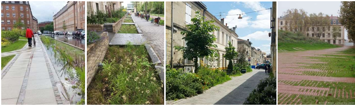
Figuur 9: Principes toepasbaar in retentiestraten met bestemmingsverkeer. Van links naar rechts: (1,2) doorlopende groenstroken die vol blijven staan zodat in de mate van het mogelijke kan geïnfiltreerd worden. Het kan nodig zijn een drainageleiding te voorzien. Ter hoogte van de ingang van de huizen worden de vakken onderbroken. (3) een sterk onthard voorbeeld uit Frankrijk (Bordeaux) waar de ontharding niet enkel voor water maar ook voor hoogstammen en voedseldragende vegetatie werd gebruikt. (4) niet overal is het wenselijk dat er water kan blijven stilstaan aan de oppervlakte. Dit gebruikspein werd sterk onthard, door het open contact met de bodem is er altijd enige infiltratie.
